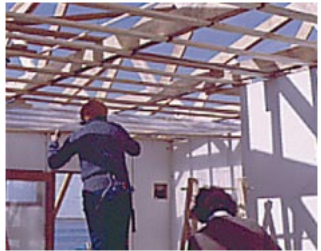
Fig. 51: Colocando polietileno como barrera de vapor
