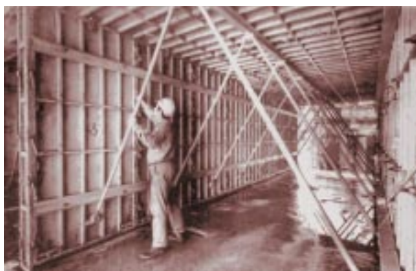
Sist. de encofrados Túnel (Integrit Argentina)
