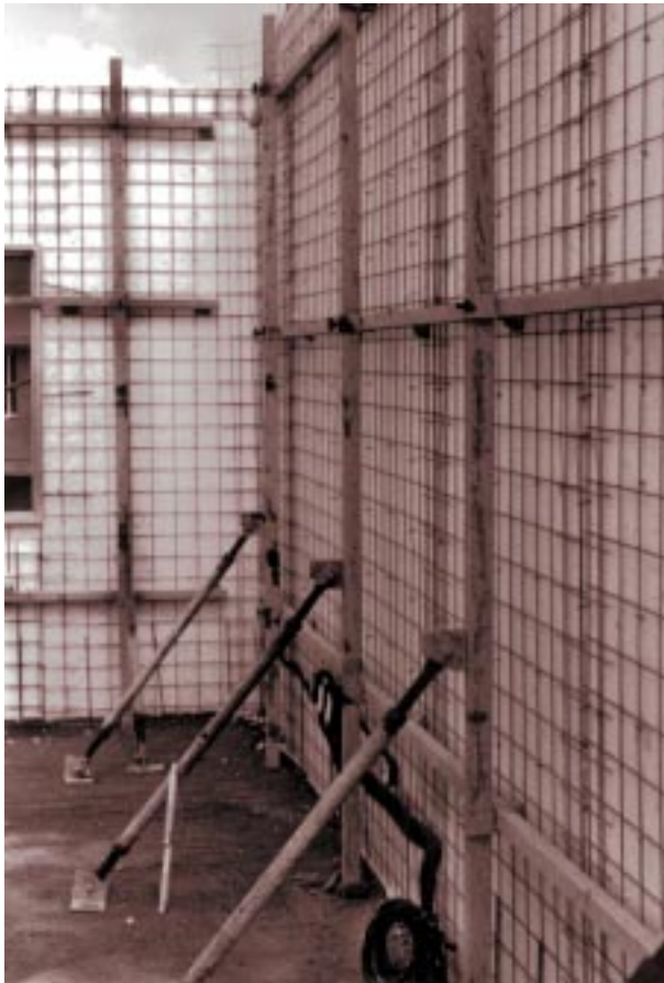
Sist. de ejecución "in situ" desde el interior y revocando los paramentos exteriores (Plastbau-España)
