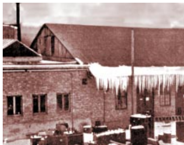
Fig. 9: Cargas de hielo sobre el borde de un techo
