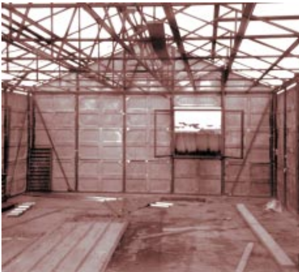
Sist. de prefabricación liviana con estructura de chapa de acero y paneles de hormigón (Súbitas-Argentina)
