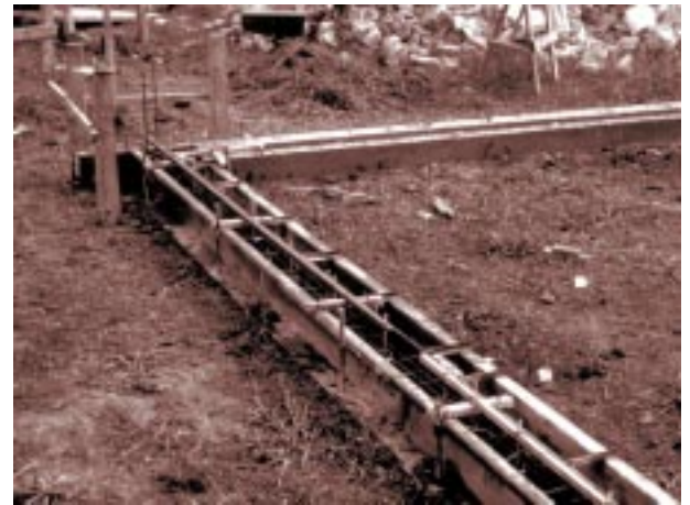
Fig. 30: Viga de fundación en sistema liviano
