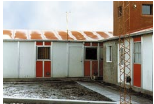
Fig. 62: Puentes térmicos en techos
