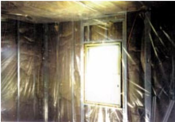
Fig. 61: Correcta colocación de barrera de vapor (Steel Wall Arg)
