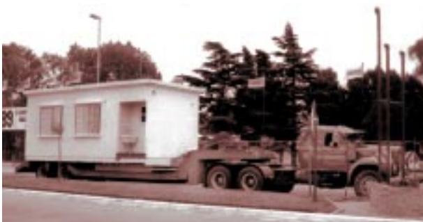
Traslado de módulos de hormigón (MO.HA. Argentina)
