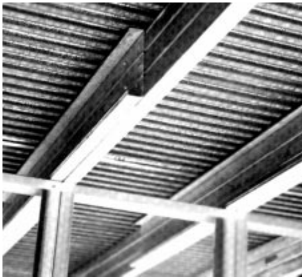
Fig. 18 b: Columnas de chapa de acero
