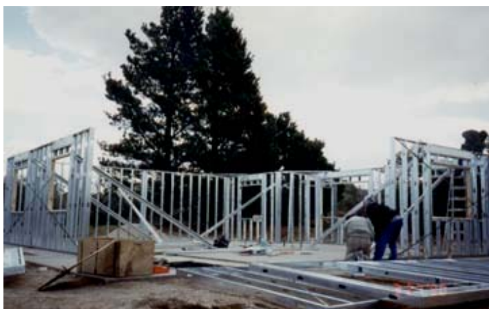
Montaje de paneles
